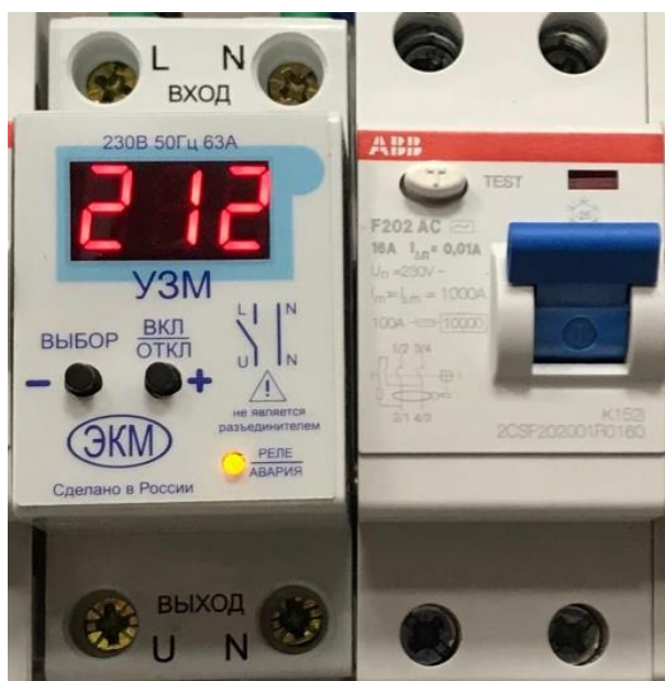
Рис. 1. Комбинация реле-напряжения и дифференциального автомата
